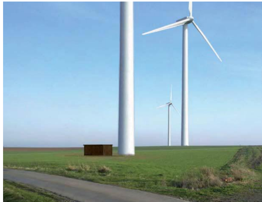
Exemple de perception d'un poste de livraison
